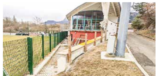
Die Terrasse wurde einladend und leichter zugänglich gestaltet.
