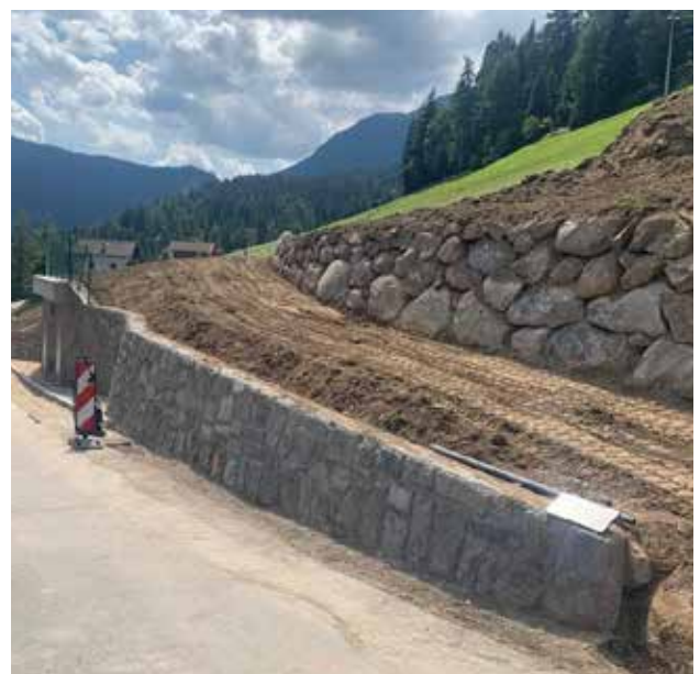
Die Arbeiten in Platzers sind abgeschlossen.
