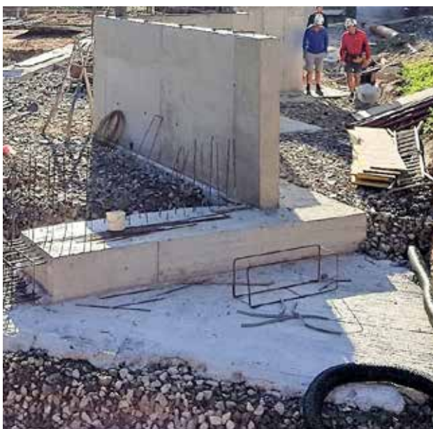
Die Bauarbeiten für den neuen Wertstoffhof schreiten voran.
