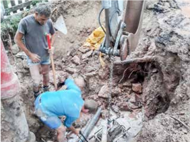
In Naraun waren Arbeiten am Trinkwassernetz nötig..
