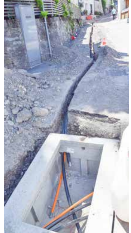
Die Arbeiten laufen auf Hochtouren.
