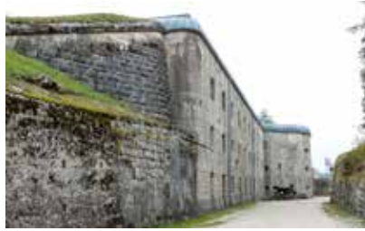
Das gut erhaltene Sperrwerk Gschwent auf der Hochfläche von Lavarone wurde zwischen 1909 und 1912 errichtet.
