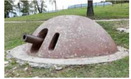
Zehn-Zentimeter-Turmhaubitze bestehend aus Panzerkuppel und Geschütz. Die Panzerkuppel war aus sehr zähem Chromnickelstahl gefertigt.
