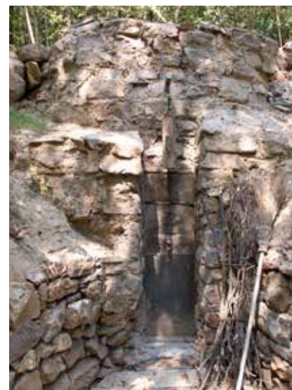
Ofenbrust und „Schiirtirl“ des renovierten Kalkofens in Graun/Kurtatsch.
