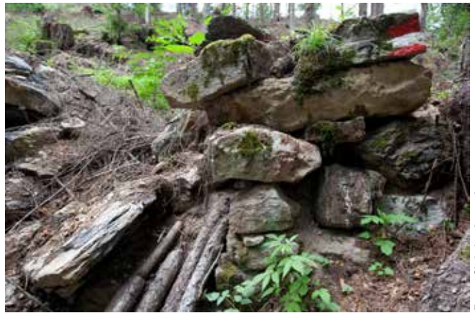
Detail der Ofenmauer. Die Mauerstärke beträgt etwa ein Meter.
